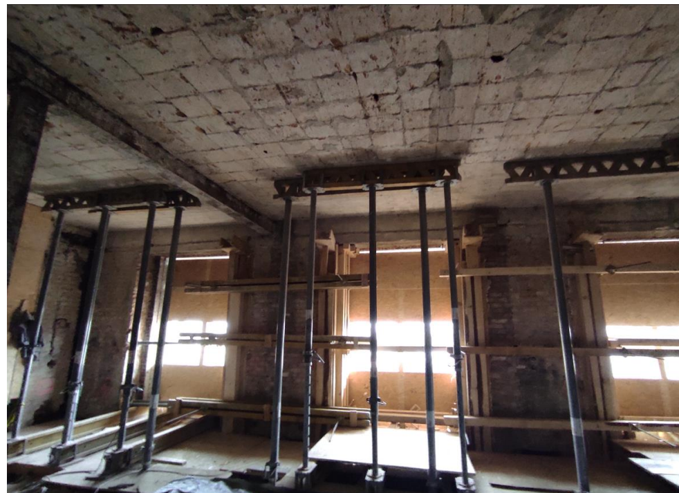
Konieczne było wykonanie wzmocnienia w budynku zabytkowym
