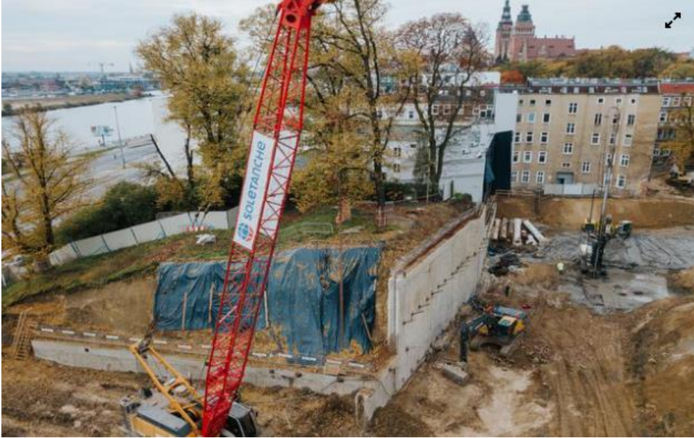
Wykonanie ścian szczelinowych, przesłony i Jet Grouting
