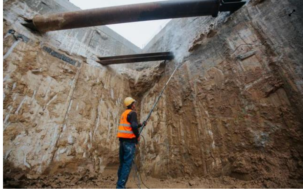
Wykonanie ścian szczelinowych, przesłony i Jet Grouting
